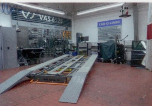
Für die Karosserievermessung setzt das Porsche Zentrum auf ein System von Car-O-Liner.
