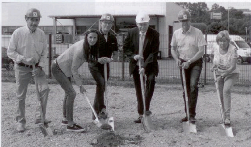
Anfang Juni erfolgte der Spatenstich für das neue Lagergebäude von Haweka Werkstatttechnik Glauchau durch (v.l.n.r.) den Ortsvorsteher des Stadtteils Niederlungwitz Uwe Wanitschka , Katja Veit (Geschäftsführerin des Bauunternehmens Hans Fuchs), Firmengründer Manfred Jirmann , Oberbürgermeister Dr. Peter Dresler , Marco Jirmann (Geschäftsführer Haweka Werkstatttechnik Glauchau) sowie Ursula Jirmann , die 1990 Initiatorin der Firmengründung war
