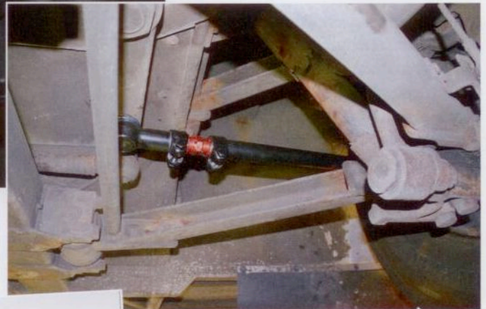
Fehler erkannt: Mit dem Auswechseln der defekten Spurstangen ist auch der erhöhte Reifenverschleiß behoben.
