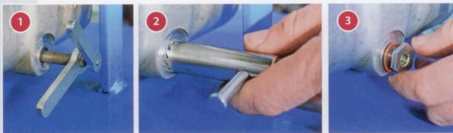
Dichtfläche bearbeiten: Gemäß der vorgegebenen Reihenfolge ist zunächst die Klammereinheit festzuziehen (1). Anschließend dreht der Mechatroniker im Uhrzeigersinn den Fräser auf der beschädigten Dichtfläche (2). Nach dem Reinigen kann er eine neue Ölablassschraube mit Dichtring in die Ölwanne eindrehen (3). Bilder: HBT
