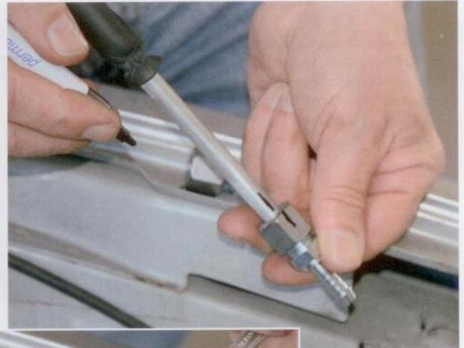
**Der Reihe nach:** Zuerst schiebt der Fachmann die Dichtungskomponenten auf die Rohrenden auf (oben), dreht sie handfest zusammen und markiert die Lage der Einzelteile anschließend mit einem Marker (oben rechts). Zum Schluss erfolgt ein Anziehen mit zwei Schraubenschlüsseln (rechts).
