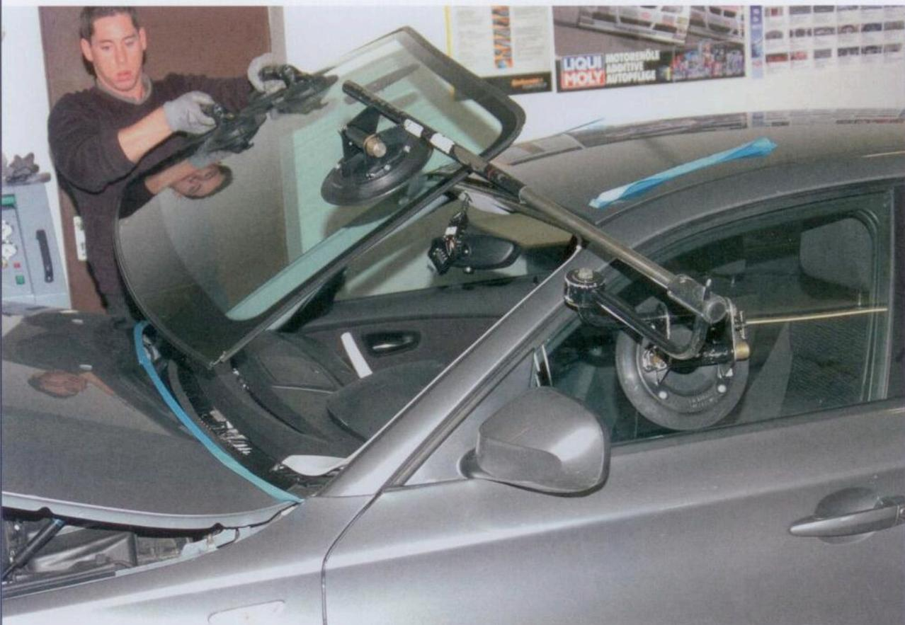
**Zweiter Mann überflüssig:** Pfiffiges Werkzeug, das einen schnellen und sicheren Glas-service ermöglicht, macht dieses Geschäft noch attraktiver. Im Bild ist eine Montagehilfe zu sehen, wie sie Carglass verwendet. Bild: Guranti
