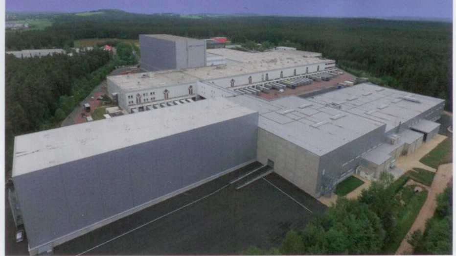
Neue Gesamtansicht des Stahlgruber Logistikzentrums
